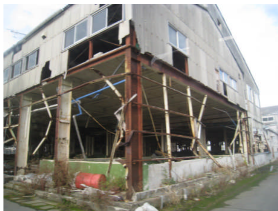
(津波で破壊された工場)
